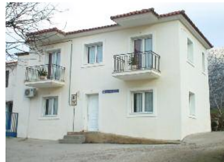
Το Κατσιακβέλειο Κοινοτικό Κτήριο - Το σπίτι της Οκτωνιάς • The Katsikavelio Communal Building - The House of Oktonia
